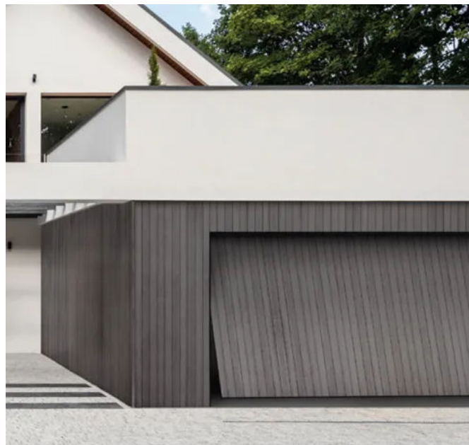
Bauseitige Holzverkleidung | Ein spezieller Torblattrahmen bietet die Möglichkeit die Garage passend zum Haus zu verbrettern
