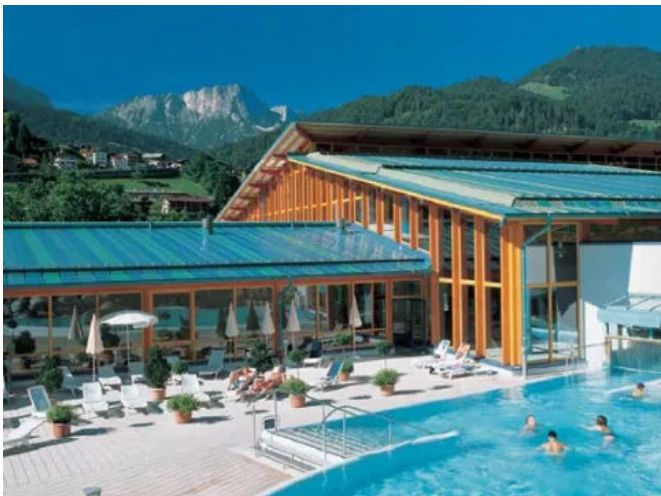
Schwimmbad, Berchtesgaden/ Deutschland
