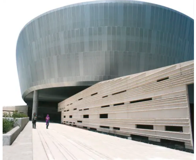
Call Center Banco de Santander, Queretaro/Mexico, Architekt: Estudio Lamela/ Springall-Lira Arquitectos, Material J73A UP®
