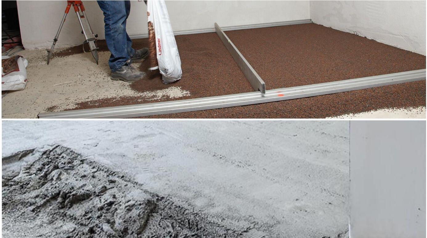
NORIT-Trockenschüttung aus Bläton und NORIT-Gebundene Schüttungen aus zementgebundener Ausgleichsmasse für niveaausgleichende, schall- und wärmedämmende Unterschichten unter den NORIT-Trockenestrichplatten oder der NORIT-Fußbodenheizung.
