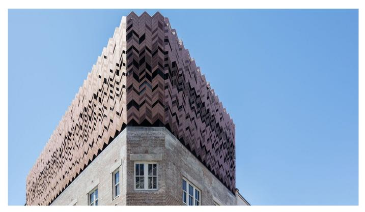
Nordic Copper ist die Produktlinie für architektonische Anwendungen von Aurubis, z.B. für Fassaden und Dächer. Eine große Auswahl an werkseitigen Oberflächenbehandlungen stattet Kupfer und Messing mit verschiedenen Oxidations- und Patinierungsstufen und Brünierungen aus. Schnell lieferbar und ab 3 m² verfügbar.
