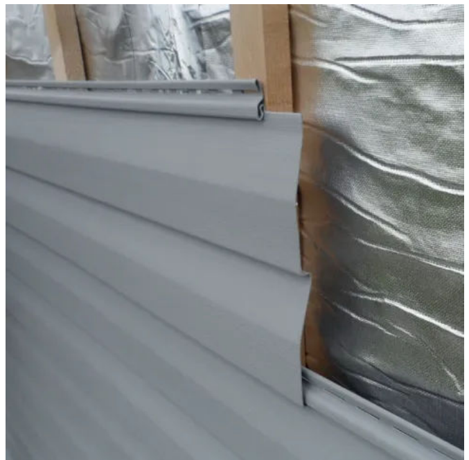
Skytech® PRO XL als Fassadenbahn, DIN EN 13859-2
