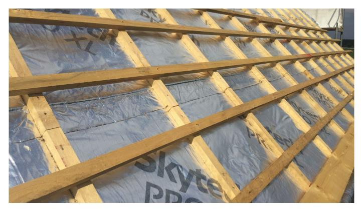
Nicht brennbare Dach-/Fassadenbahnen Skytech® PRO XL / AirTex® A2 und Dampfsperren AirTex® A2
