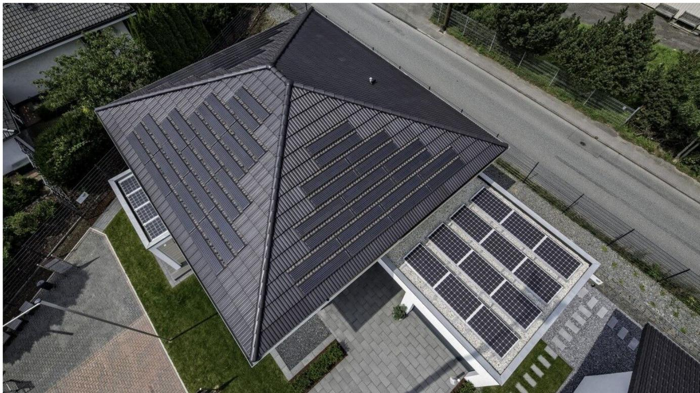
Nelskamp PV Module zur Strom- und Wärmeerzeugung auf dem Dach. Die gebäudeintegrierten Photovoltaiksysteme fügen sich harmonisch ins Deckbild.
