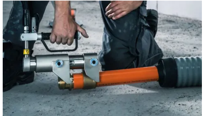
Zur Verbindung der Rohre wird die bewährte REHAU Verbindungstechnik Schiebehülse eingesetzt.
