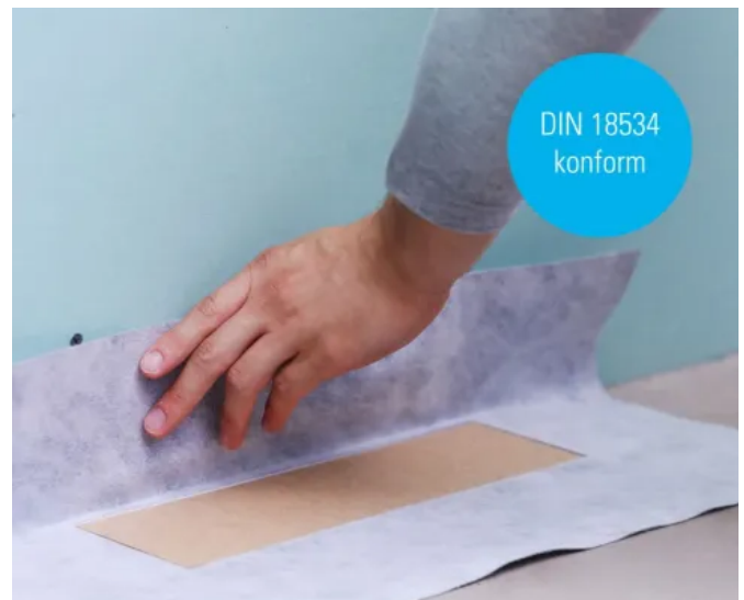
Die flexible DallFlex 2.0-Dichtmanschette nimmt die Verbund- sowie Bahnenabdichtung gemäß DIN 18534 auf.
