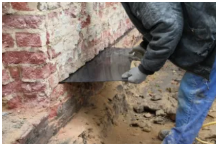
Einbringen einer kapillarwasserdichten Sperrschicht aus glasfaserverstärkten Kunststoffplatten
