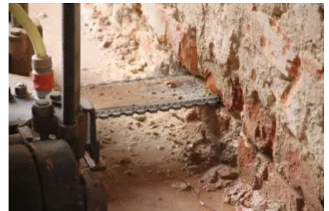
Durchtrennen des Mauerwerks in Abschnitten mit der PRINZ-Kettensäge, fahrbar
