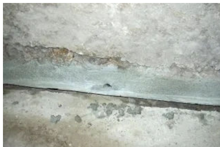
Allseitige Vermörtelung der Schnittfuge
