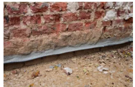
Vermörtelung der Schnittfuge
