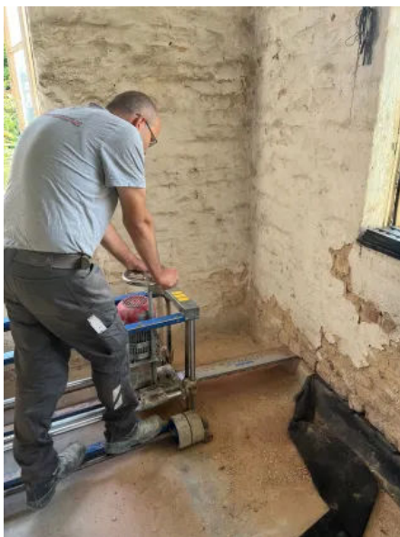
Durchtrennen des Mauerwerks in Abschnitten mit der PRINZ-Kettensäge
