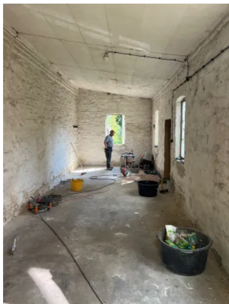
Mauerwerkstrockenlegung im Sägeverfahren
