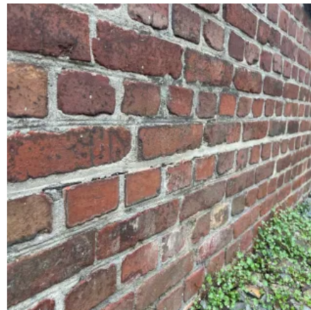
Allseitige Vermörtelung der Schnittfuge
