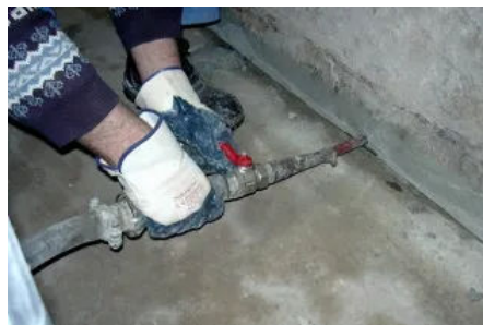
Formschlüssige Hohlraumverpressung mit einer geeigneten Mörtelpumpe
