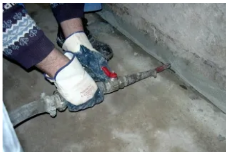
Formschlüssige Hohlraumverpressung mit einer geeigneten Mörtelpumpe
