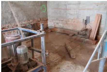
Durchtrennen des Mauerwerks in Abschnitten mit der PRINZ-Diamant-Seilsäge
