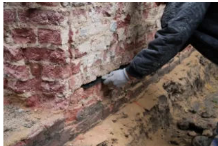
Sperrschicht-Überlappung der Plattengröße mindestens 10 cm
