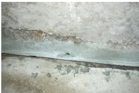
Allseitige Vermörtelung der Schnittfuge
