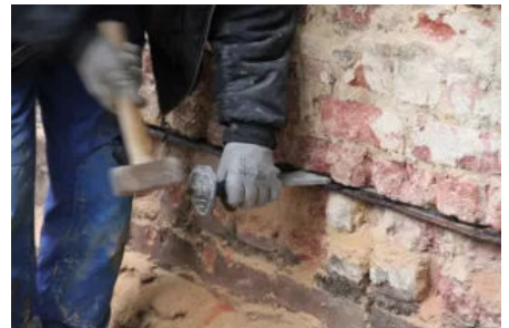
Verkeilen der Schnittfuge mit statisch belastbaren Kunststoffkeilplatten
