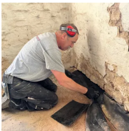
Einbringen einer kapillarwasserdichten Sperrschicht aus glasfaserverstärkten Kunststoffplatten (Dicke \geq 1,2 mm) oder HD-Polyethylenplatten (Dicke 1,5 bzw. 2,0 mm) inkl. Putzüberstand. Überlappung der Plattengröße \geq 10 cm.
