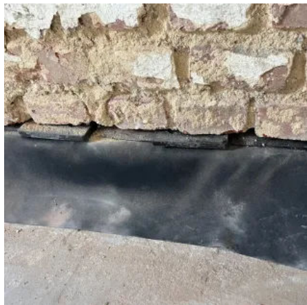
Verkeilen der Schnittfuge
