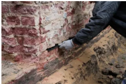
Sperrschicht-Überlappung der Plattengröße mindestens 10 cm
