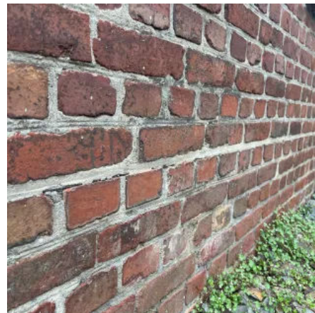
Allseitige Vermörtelung der Schnittfuge
