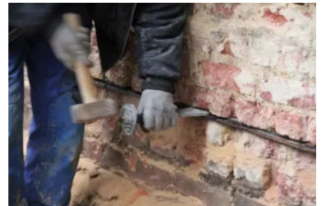
Verkeilen der Schnittfuge mit statisch belastbaren Kunststoffkeilplatten
