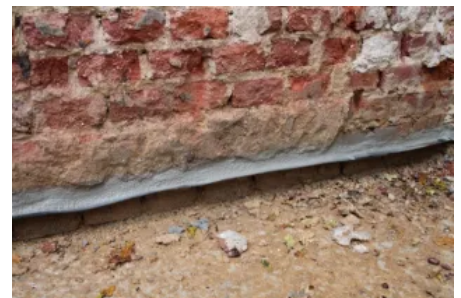
Vermörtelung der Schnittfuge
