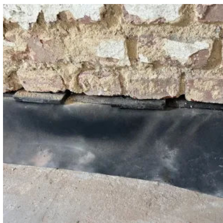
Verkeilen der Schnittfuge
