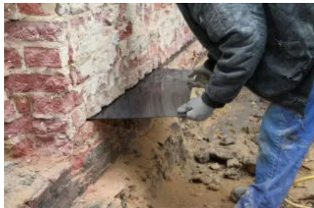
Einbringen einer kapillarwasserdichten Sperrschicht aus glasfaserverstärkten Kunststoffplatten
