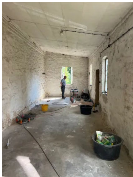
Mauerwerkstrockenlegung im Sägeverfahren
