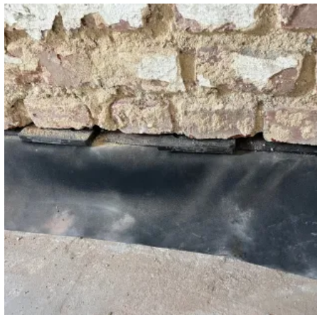
Verkeilen der Schnittfuge
