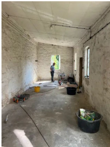
Mauerwerkstrockenlegung im Sägeverfahren
