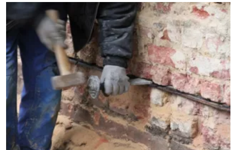
Verkeilen der Schnittfuge mit statisch belastbaren Kunststoffkeilplatten
