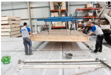
Die HBV-Elemente SupraFloor® werden präzise aus Holz im Werk von ERNE vorgefertigt...
