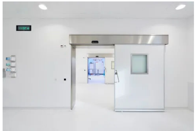
Hohe Komplexität der Planung und Technik, hohe technische und hygienische Anforderungen
