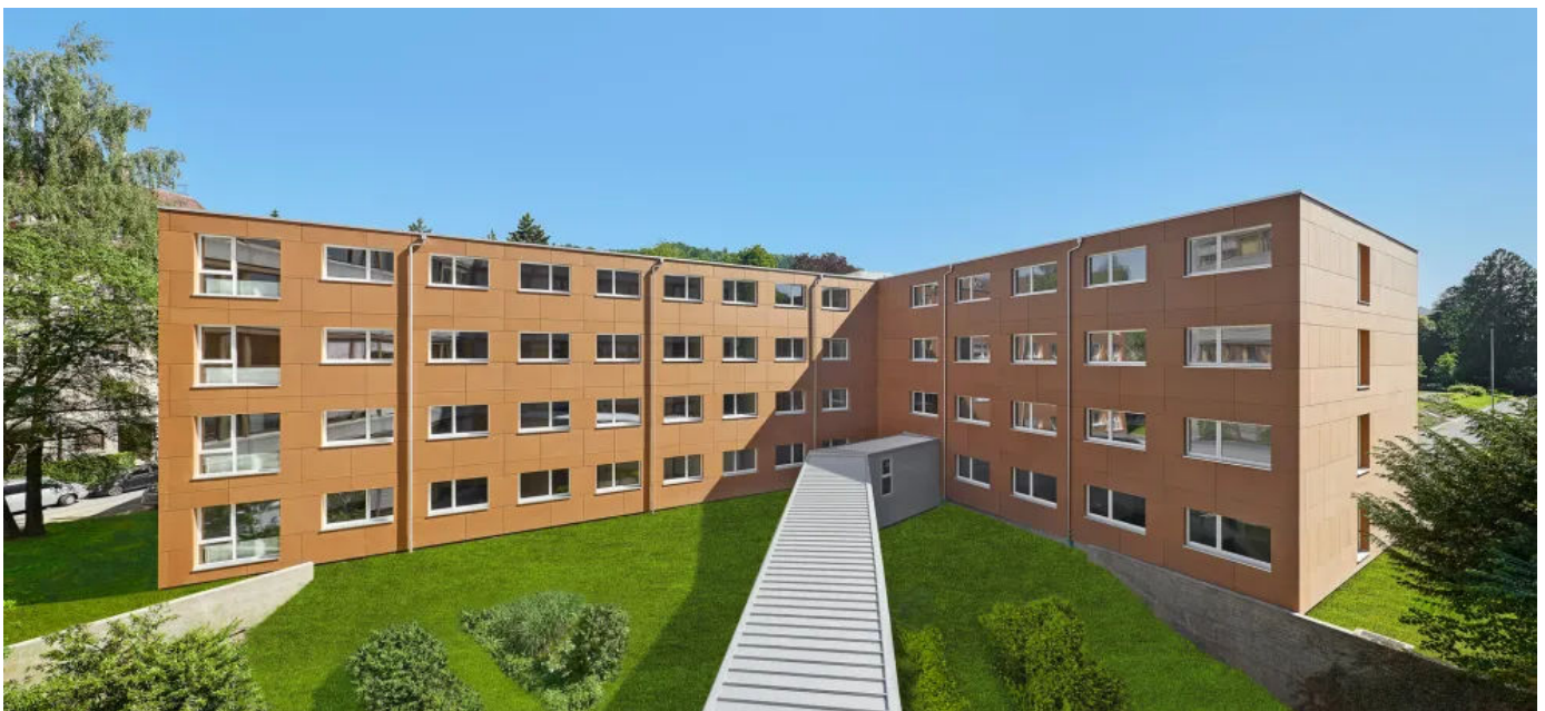
Dank hochwertigem Baustandard ist das Modulgebäude der Geriatrie Klinik St. Gallen geeignet für temporäre sowie auch dauerhafte Nutzungen.
