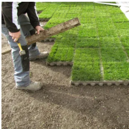
Schnelle händische oder maschinelle Verlegung
