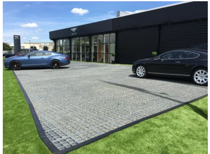
Außenanlage eines Autohauses
