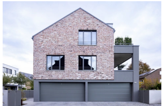
Vierfamilienhaus, Meerbusch - Planung: Dipl.-Ing Uwe Meyer, Meerbusch | Foto: Caparol Farben Lacke Bautenschutz/Andreas Wiese
