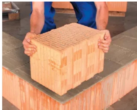
Mauerstein vollflächig auflegen
