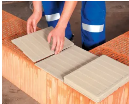
Auflegen der maxit mörtelpads
