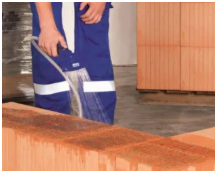
Mauersteine befeuchten
