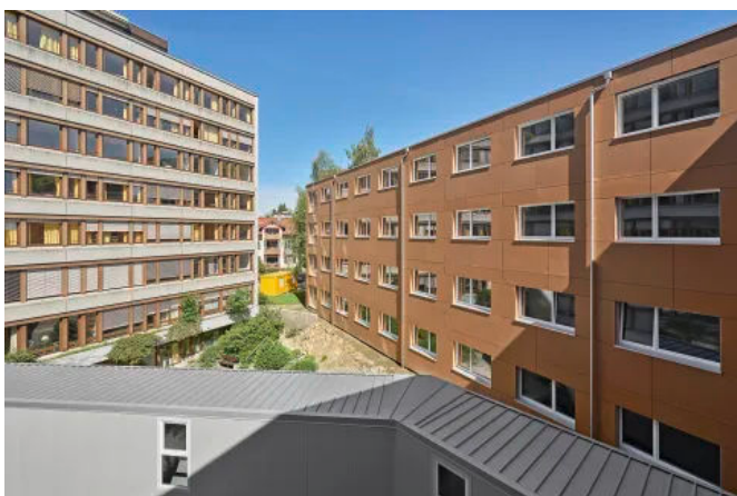
Temporäres Interimsgebäude in Modulbauweise während der Umbauphase des Klinikums
