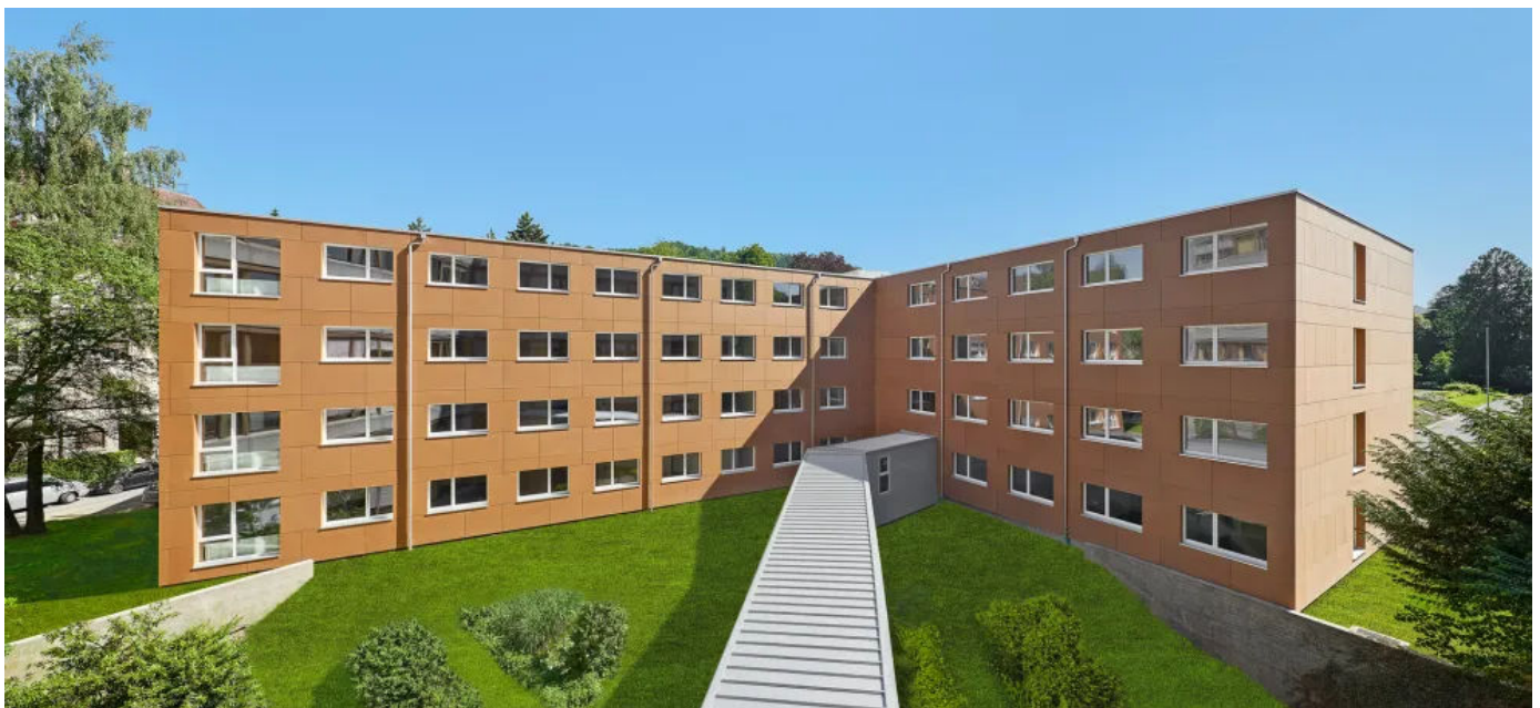
Dank hochwertigem Baustandard ist das Modulgebäude der Geriatrie Klinik St. Galleneignen für temporäre sowie auch dauerhafte Nutzungen.
