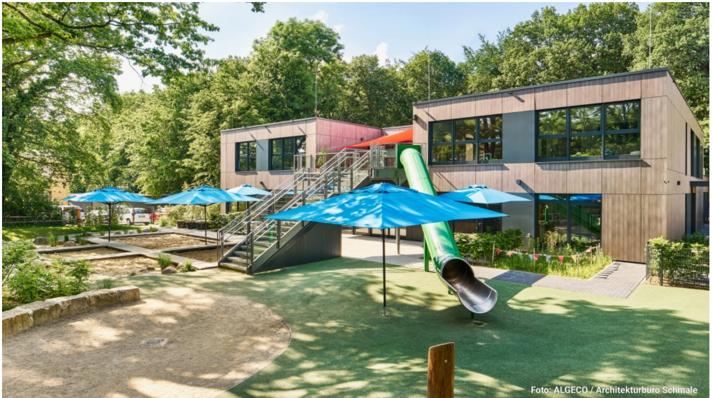
Individuelle Modulbauten mit Charakter; Foto: ALGECO / Architekturbüro Schmale
