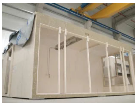
Industrielle Vorfertigung inklusive Elektroinstallationen
