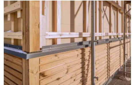
Individuelle Fassade als Vorhangkonstruktion
