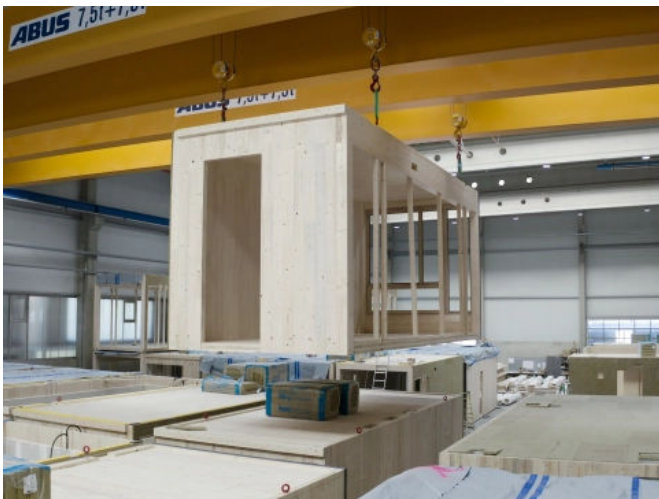
KLEUSBERG Modulfertigung in hoch automatisierter Produktion
