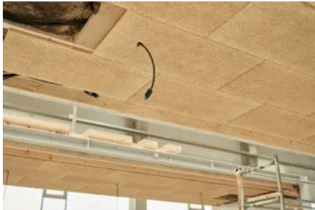
Vorgefertigtes Deckenelement mit Abhangdecke und Elektroinstallation
