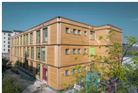
Hausburg-Grundschule in Berlin als Holzmodulbau mit vorgehängter Fassade
