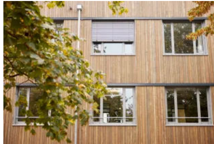
Der Neubau wurde als Holz-Massiv-Tafelbau mit vorgehängter Holzfassade realisiert.
