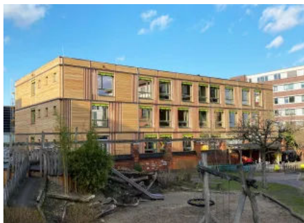
Die Fassade wurde als offene Rhombuslattung aus Lärchenholz realisiert.
