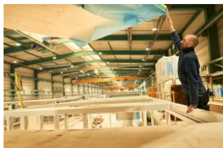
Stahl verleiht den Modulen statische Stabilität.
