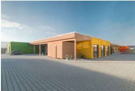
Realisiert in Holzmodulbauweise: Kita Spaichingen
