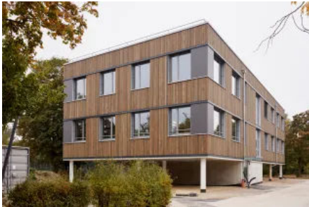
Holzmodulbau der Hochschule Augsburg auf Fundamenten und Stützen aus Stahlbeton
