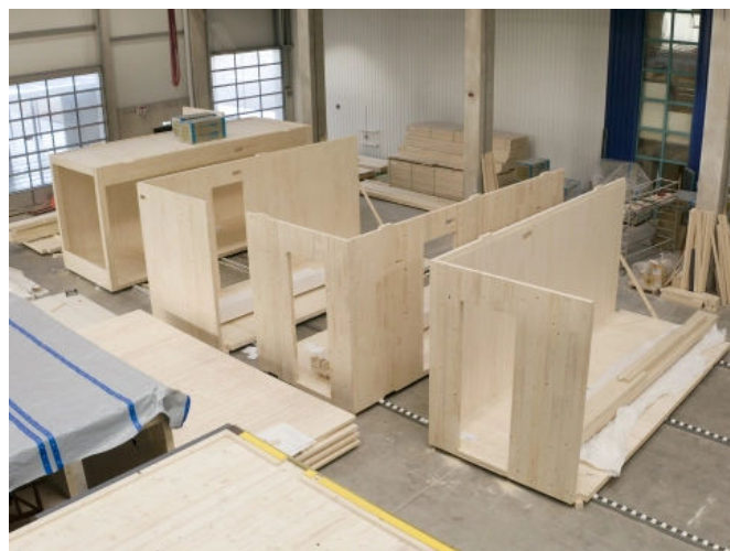
Entstehung der Holzmodule aus einzelnen Brettschichtholztafeln
