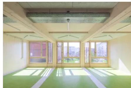
Im Inneren der Schule blieb der Baustoff Holz weitestgehend sichtbar.
