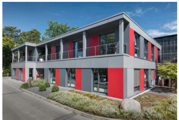
Aufstockung Bürogebäude Menke, Berlin
