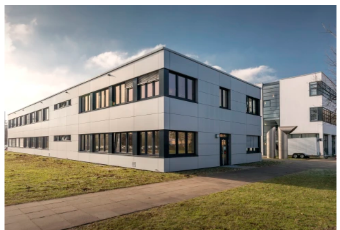
Aufstockung Seminargebäude, Hochschule Hannover
