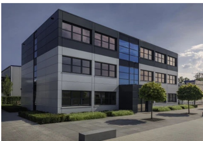
Aufstockung Bürogebäude KLEUSBERG, Remseck
