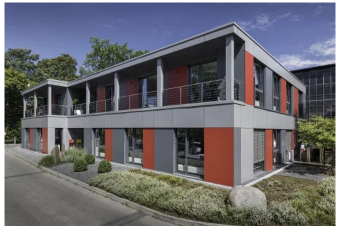
Aufstockung Bürogebäude Menke, Berlin
