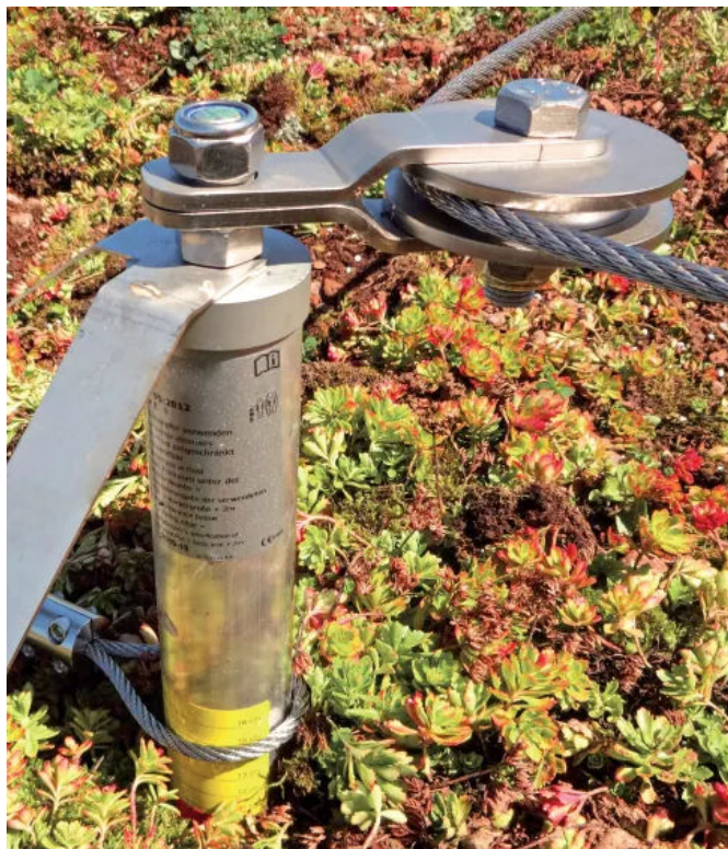
Absturzsicherung Contec.safe-System
