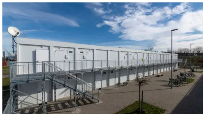
4 Containeranlagen - Erweiterung bestehender Asylunterkunft
