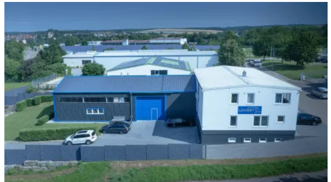
Lager- und Logistikhalle - Modulare Raumlösungen
