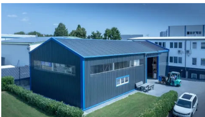
Lager- und Logistikhalle - Modulare Raumlösungen
