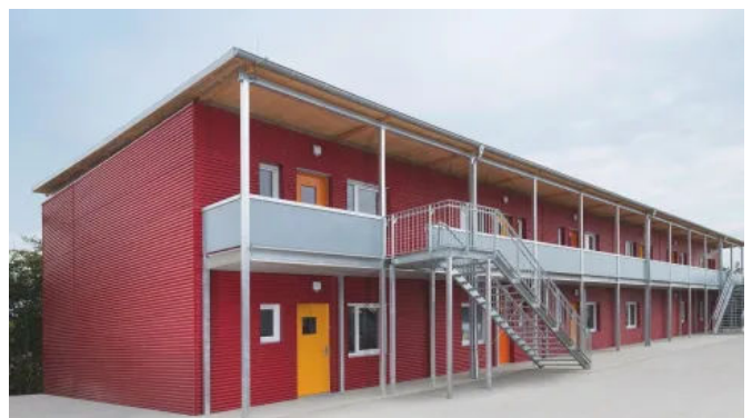
Wohnraum und Unterkünfte in Modulbauweise
