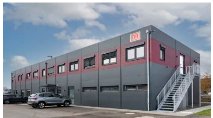
Konzerngelände der DB Netz AG in Trier - Flexible Büros für modernes Arbeiten (© Losberger De Boer)
