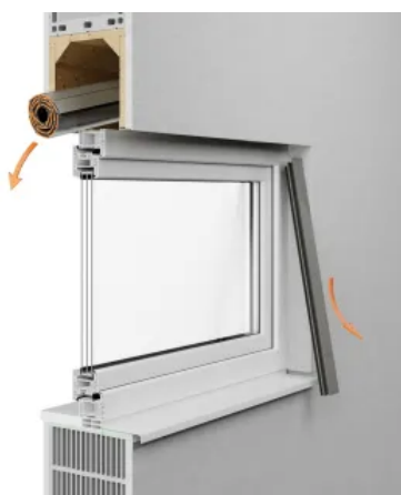
Alten Rollladen aus Kasten entfernen.
