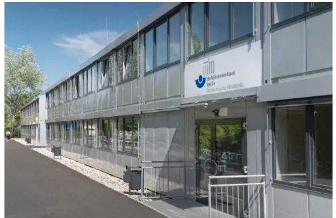
PLUS Mieteinheiten sind standardgemäß mit einer Glattblech-Kassettenfassade an den Fenster- sowie Profil-Paneelblech an den Längsseiten ausgeführt. (© Rüdiger Mosler)
