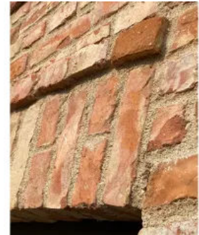
Anwendungsbeispiel: ReUse Ziegelsteine im Denkmalschutz
