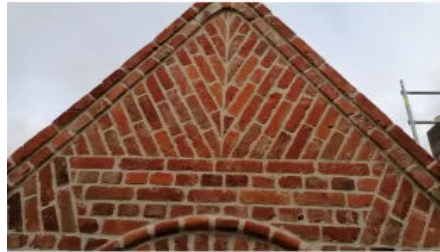
Anwendungsbeispiel: ReUse Ziegelsteine im Denkmalschutz
