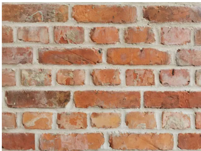
ReUse Ziegel - rot - "Tetenbüll"
