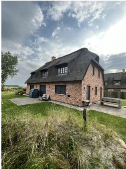
ReUse Ziegel - rot - "Tetenbüll"
