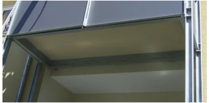
Balkonerweiterung von unten
