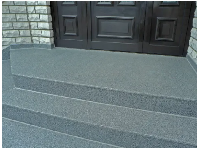
Treppenbelag mit Podestplatte im Eingangsbereich
