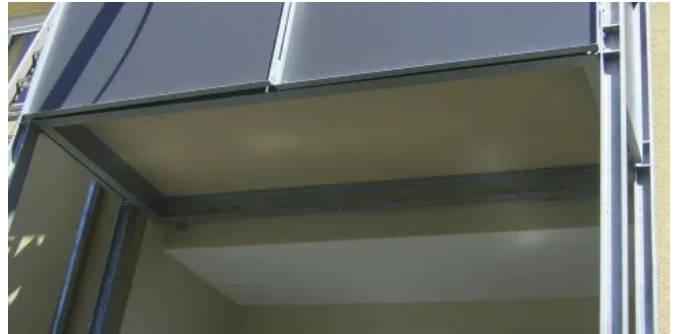
Balkonerweiterung von unten
