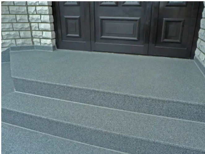
Treppenbelag mit Podestplatte im Eingangsbereich
