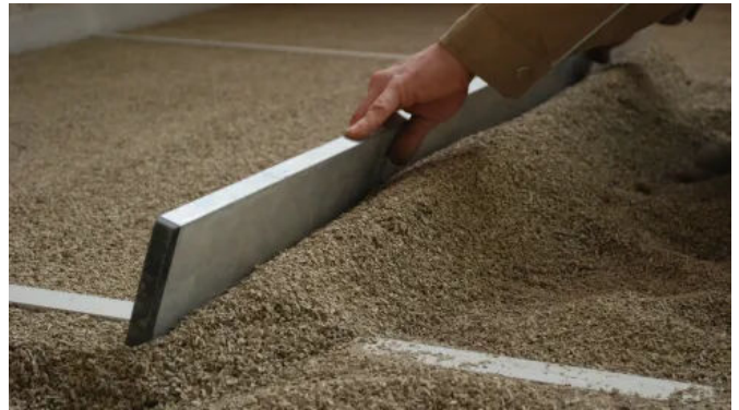
CW1000: Als Ausgleichsschüttung für niedrige Aufbauten
