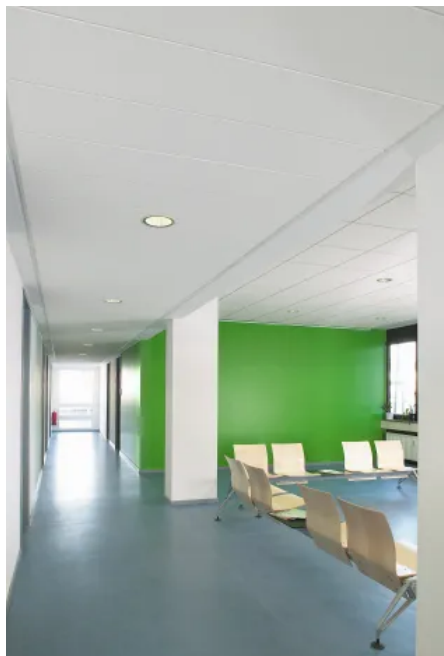
S 6b: freigespanntes System
