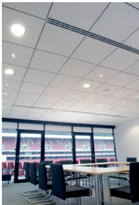
S 15 b OWAline: sichtbares System
