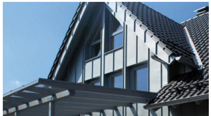
Scharen in Stehfalztechnik
