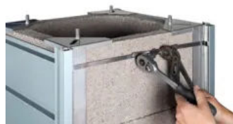
Kaminseitenverkleidungen aus Kupfer, Zink, Zink vorbewittert oder aus Aluminium
