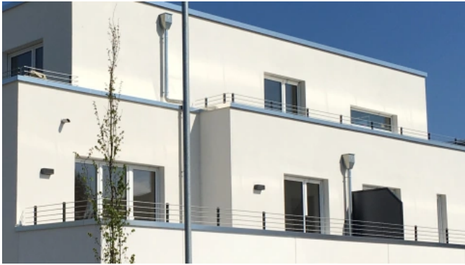
Referenzbeispiel mit Lübke Mauerabdeckungen
