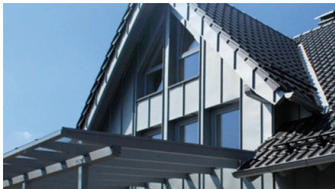
Scharen in Stehfalztechnik
