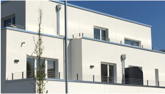
Referenzbeispiel mit Lübke Mauerabdeckungen
