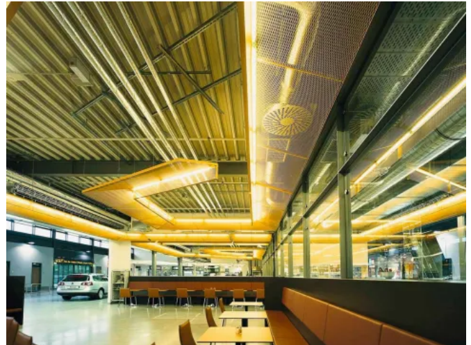
Deckensegel in Kombination mit einem Lichtleistsystem: TSA (Referenz Baden Airpark)
