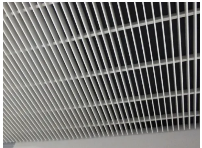
Lamellensystem mit Stegbreite von 5 mm oder 9 mm: System K5/K9 FA
