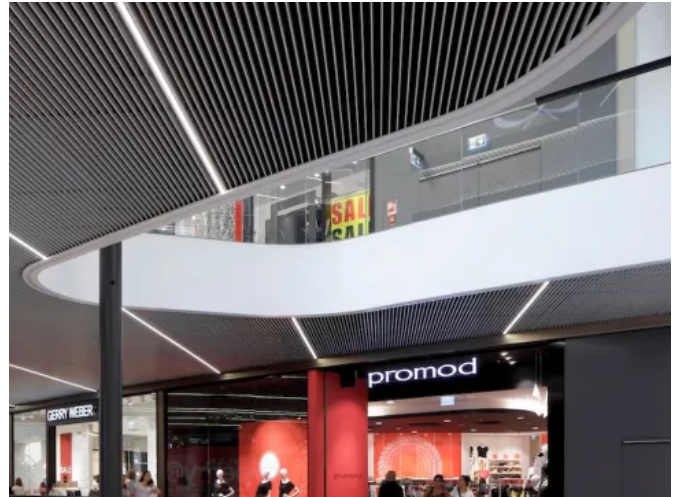
Einzellamellen zur bauseitigen Steckmontage: System K9
