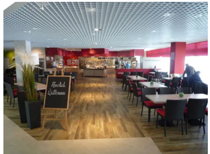
Schnelle Verlegung mit systemeigener Unterkonstruktion: K-Raster
