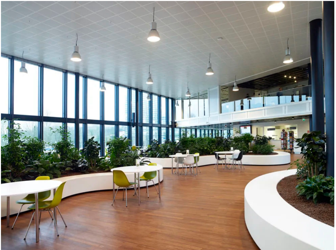
OWAtecta System S 45 sichtbar (Einlegesystem) MetaldeckeMetaldecke Rd1522 – rund gelocht, verzinktes Stahlblech, pulverbeschichtet, weiß (ähnl. RAL 9003)
