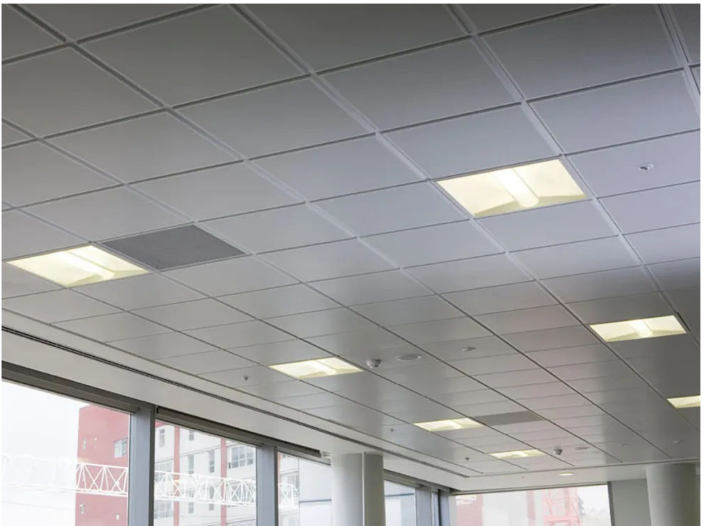
OWAtecta System S 33 sichtbar (Einlegesystem) Metaldecke Rg0702 – perforiert, verzinktes Stahlblech, pulverbeschichtet, weiß (ähnl. RAL 9003)
