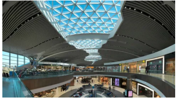
Luxalon® Baffeldecke am Flughafen Rom Fiumicino Gate C03
