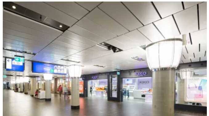
Luxalon® Langfeldplatten in der Poortvrije Passage in Amsterdam, Niederlande, Architekt: bethem crouwel
