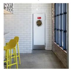
Die Pendelfunktion wird durch spezielle Bänder sichergestellt, die ein Aufschwingen der Tür in beide Richtungen ermöglicht.
