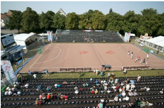
Aufbau einer Handball-Arena im Außenbereich
