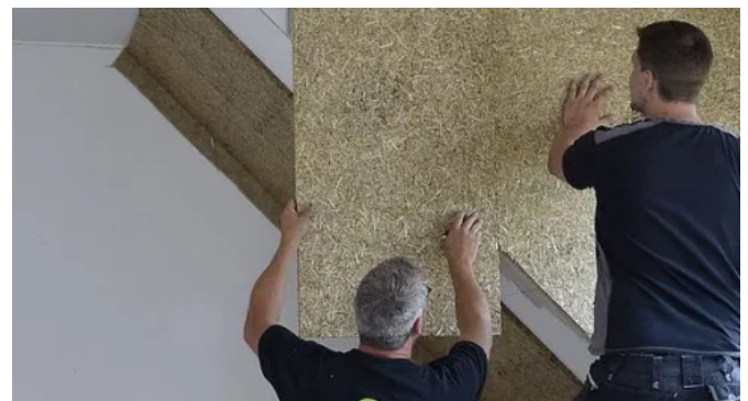
Innensanierung in den Büroräumen Franken Maxit, Azendorf I Fläche ca. 50 m 2
