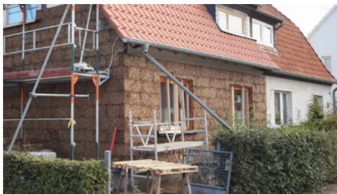
Fassadensanierung, Lüneburg | Fläche ca. 80 m 2
