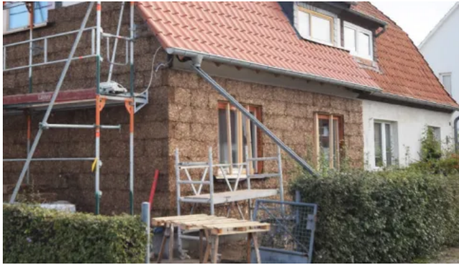
Fassadensanierung, Lüneburg | Fläche ca. 80 m 2
