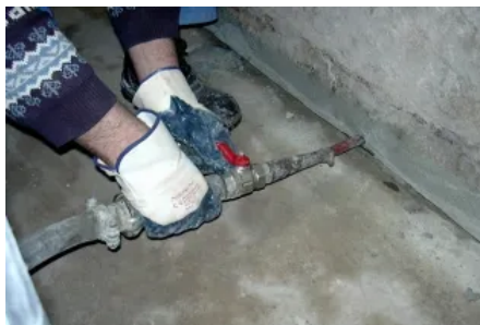
Formschlüssige Hohlraumverpressung mit einer geeigneten Mörtelpumpe
