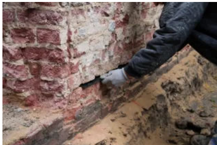
Sperrschicht-Überlappung der Plattengröße mindestens 10 cm
