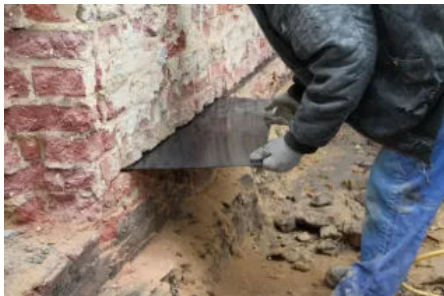
Einbringen einer kapillarwasserdichten Sperrschicht aus glasfaserverstärkten Kunststoffplatten
