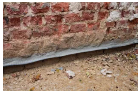
Vermörtelung der Schnittfuge
