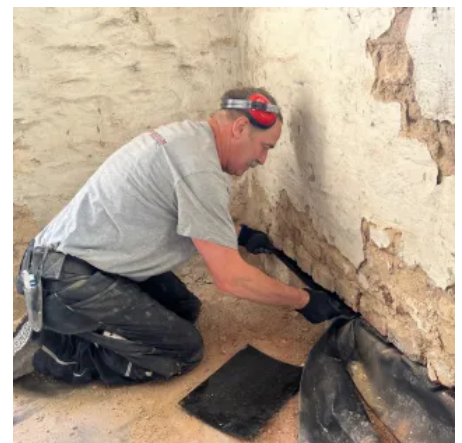
Einbringen einer kapillarwasserdichten Sperrschicht aus glasfaserverstärkten Kunststoffplatten (Dicke \geq 1,2 mm) oder HD-Polyethylenplatten (Dicke 1,5 bzw. 2,0 mm) inkl. Putzüberstand. Überlappung der Plattengröße \geq 10 cm.
