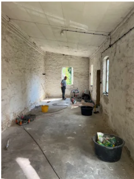
Mauerwerkstrockenlegung im Sägeverfahren
