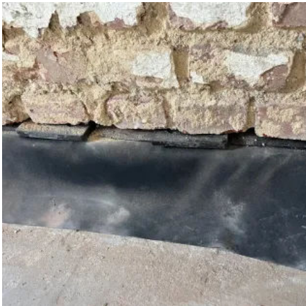
Verkeilen der Schnittfuge
