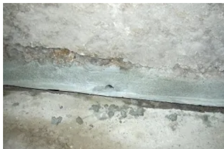
Allseitige Vermörtelung der Schnittfuge
