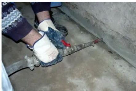
Formschlüssige Hohlraumverpressung mit einer geeigneten Mörtelpumpe
