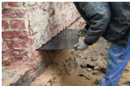
Einbringen einer kapillarwasserdichten Sperrschicht aus glasfaserverstärkten Kunststoffplatten
