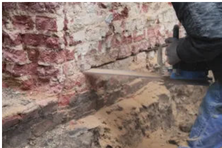
Durchtrennen des Mauerwerks in Abschnitten mit der PRINZ-Kettensäge, handgeführt
