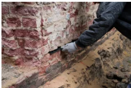
Sperrschicht-Überlappung der Plattengröße mindestens 10 cm
