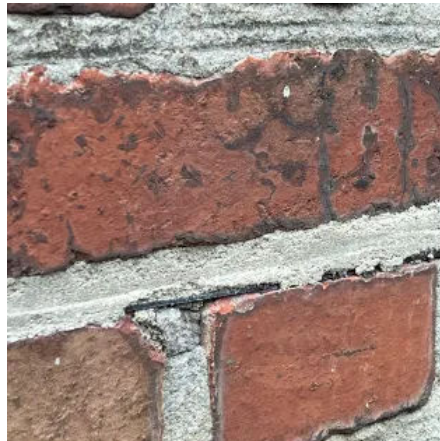
Allseitige Vermörtelung der Schnittfuge
