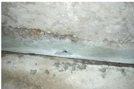
Allseitige Vermörtelung der Schnittfuge
