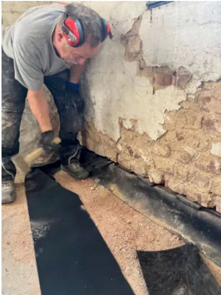
Verkeilen der Schnittfuge mit statisch belastbaren Kunststoffkeilplatten im Abstand von \leq 25 cm über den gesamten Mauerquerschnitt (Belastbarkeit \geq 500 kp/cm 2 ).
