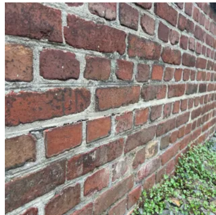
Allseitige Vermörtelung der Schnittfuge
