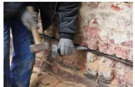
Verkeilen der Schnittfuge mit statisch belastbaren Kunststoffkeilplatten
