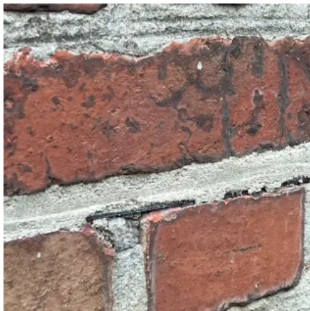
Allseitige Vermörtelung der Schnittfuge
