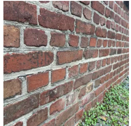
Allseitige Vermörtelung der Schnittfuge
