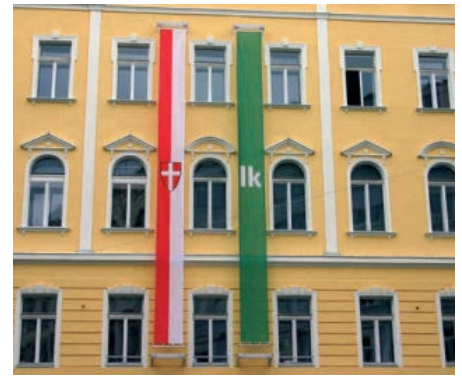
Transparentanlage am Gebäude der Landwirtschaftskammer, Wien
