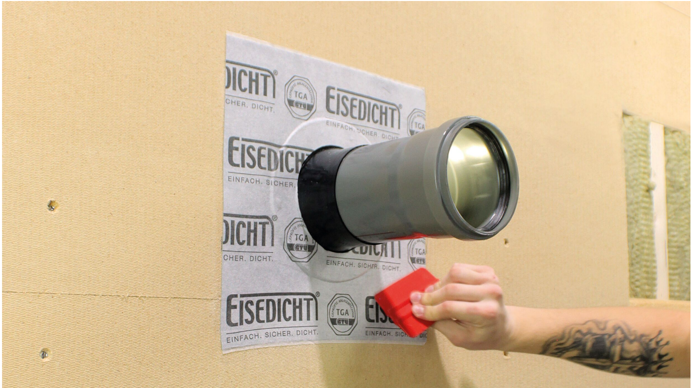
Luftdichtungsmanschetten zur Abdichtung von Durchbrüchen in Wänden und Decken
