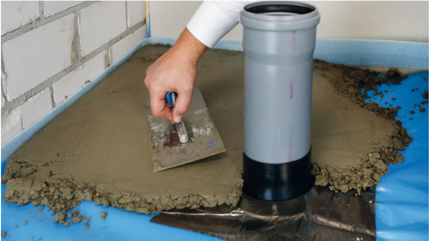
Luftdichtungsmanschetten zur Abdichtung von Durchbrüchen im Bodenbereich
