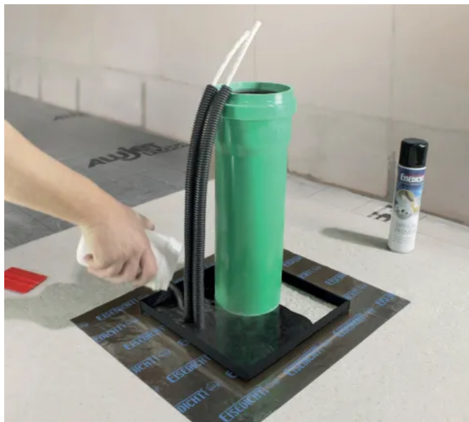
VergussDICHT bei eng nebeneinander liegenden Versorgungsleitungen
