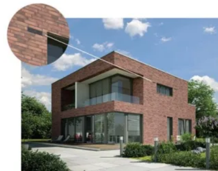
Fassadengitter plan in der Klinkerfassade
