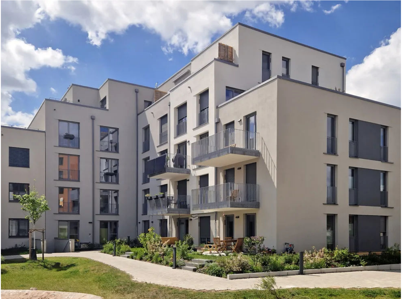
Moderne Wohngebäude mit hohem Effizienzstandard KfW-40 und kontrollierte Be- und Entlüftung mit Wärmerückgewinnung.
