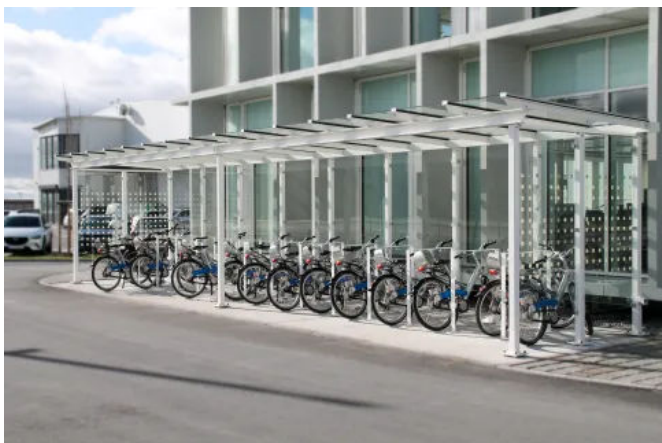
Überdachungssystem Passau mit Fahrrad-Anlehnbügel
