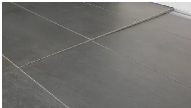
BLANKE AQUA-KEIL verbaut
