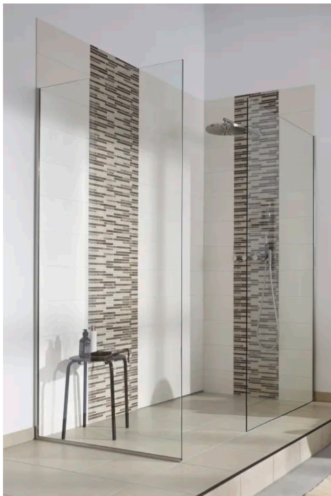
BLANKE AQUA-GLAS verbaut
