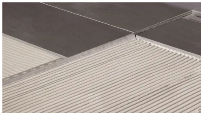
BLANKE AQUA-KEIL verbaut
