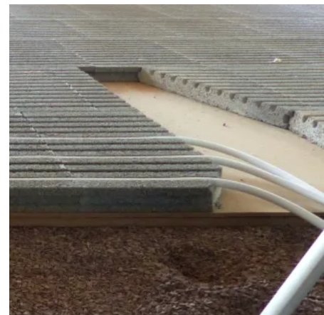
LITHOWOOD: Aufbau im Querschnitt
