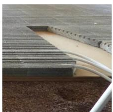
LITHOWOOD: Aufbau im Querschnitt
