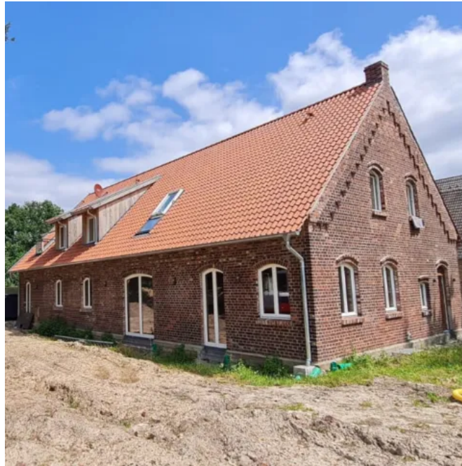
Umgenuetzter und sanierter Stall.
