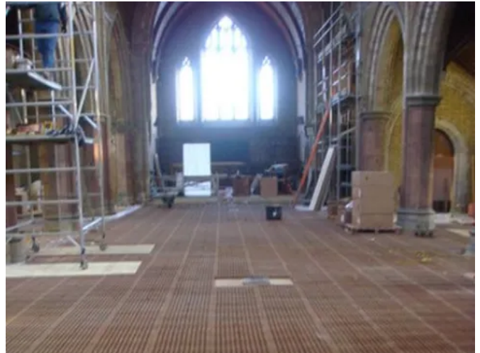
Sanierung eines Kirchenschiffs
