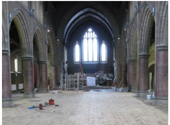
Sanierung eines Kirchenschiffs
