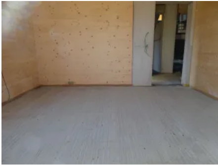
Abgespachtelter Lithotherm Boden für verklebte Bodenbeläge.
