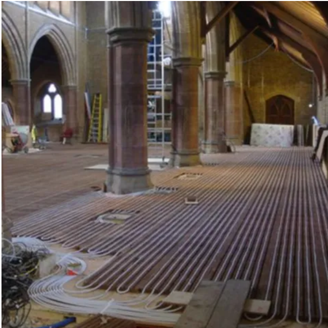
Installation der Lithotherm Trockenbau-Fußbodenheizung im historischen Kirchenschiff.
