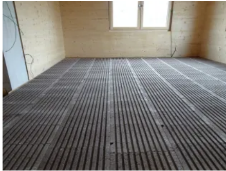
Lithotherm Formplatten verlegt.
