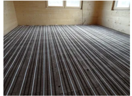
Das Lithotherm Systemrohr wird in den vorgefertigten Rillen verlegt.
