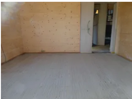
Abgespachtelter Lithotherm Boden für verklebte Bodenbeläge.
