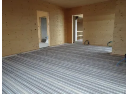
Lithotherm Boden mit Holzprofileleisten.
