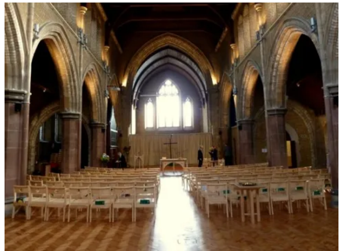
Sanierung eines Kirchenschiffs
