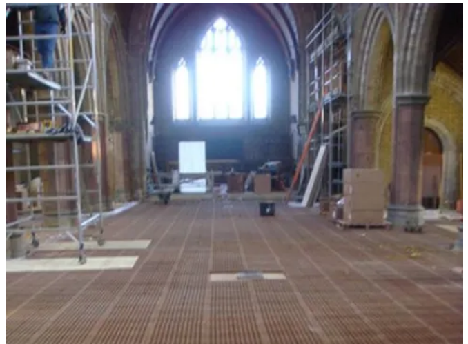
Sanierung eines Kirchenschiffs
