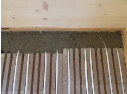
Randbereich verfüllt mit Lithowood Kalksplittschüttung und PCI Novoment Z3.
