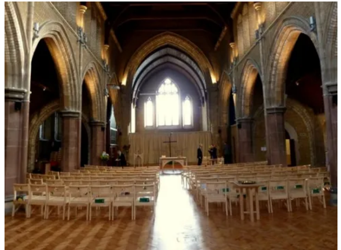
Sanierung eines Kirchenschiffs
