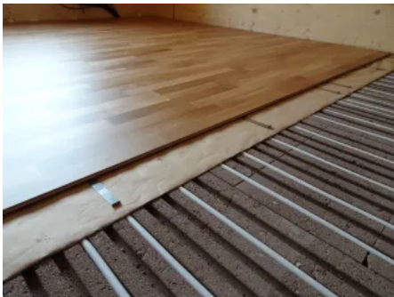
Schwimmend verlegtes Mehrschichtparkett auf Isolena Trittschalldämmung.
