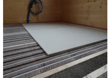
Auf der Gipsfaserplatte können bspw. Teppichböden verlegt werden.
