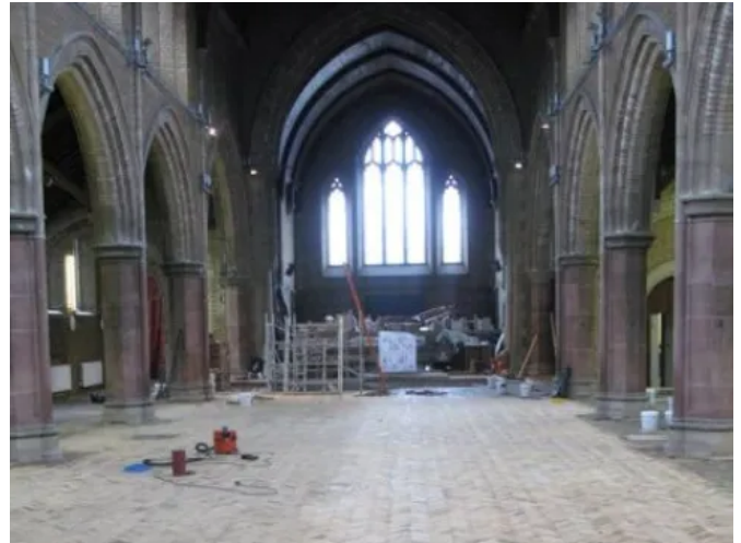
Sanierung eines Kirchenschiffs
