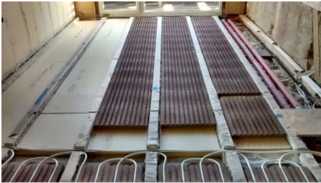
Die Lithotherm Formplatten können zwischen einer vorhandenen Balkenlage verlegt werden.
