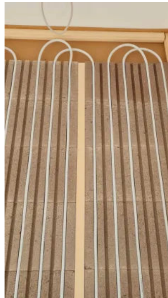
Das Lithotherm Systemrohr wird in die vorgefertigten Rillen eingelegt.
