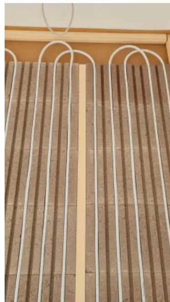
Das Lithotherm Systemrohr wird in die vorgefertigten Rillen eingelegt.
