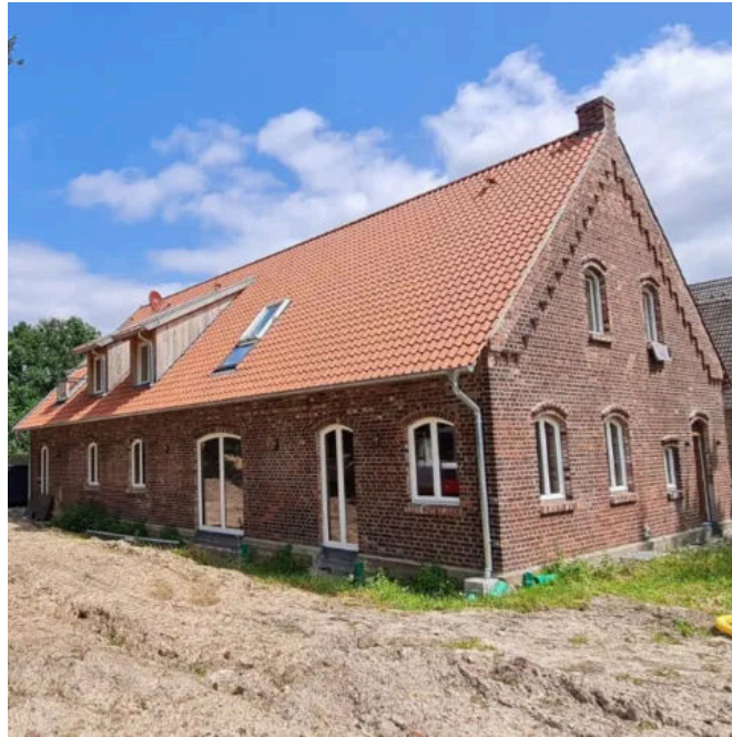
Umgenuetzter und sanierter Stall.
