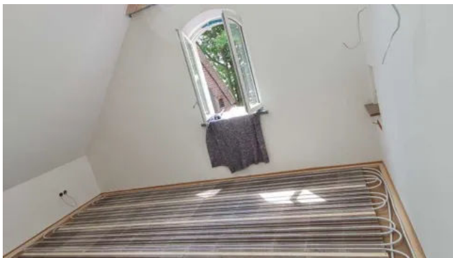
Verlegung der Fußbodenheizung im Trockenbausystem.
