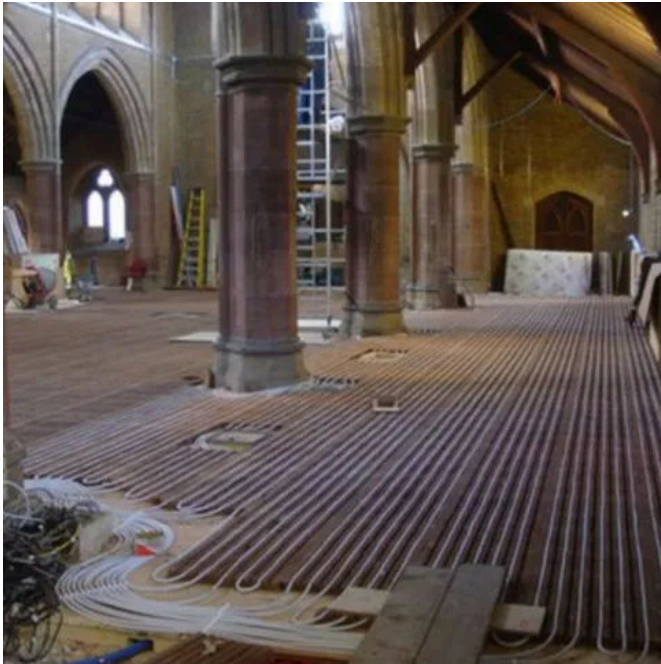
Installation der Lithotherm Trockenbau-Fußbodenheizung im historischen Kirchenschiff.
