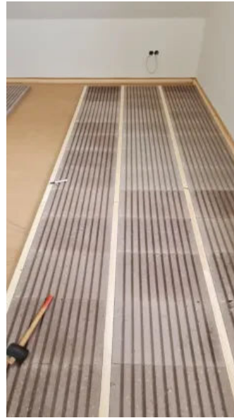
Auf den Holzprofileleisten wird der Dielenboden aufgeschraubt.
