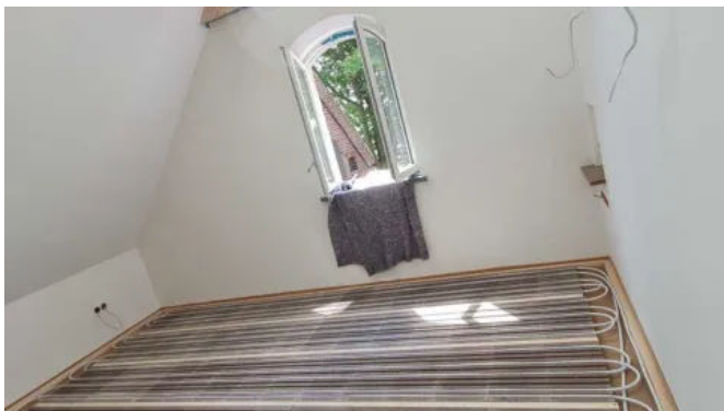
Verlegung der Fußbodenheizung im Trockenbausystem.
