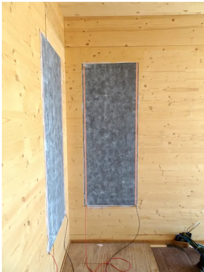
Infrartheizung an Wand
