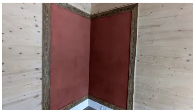
Infrartheizung verputzt
