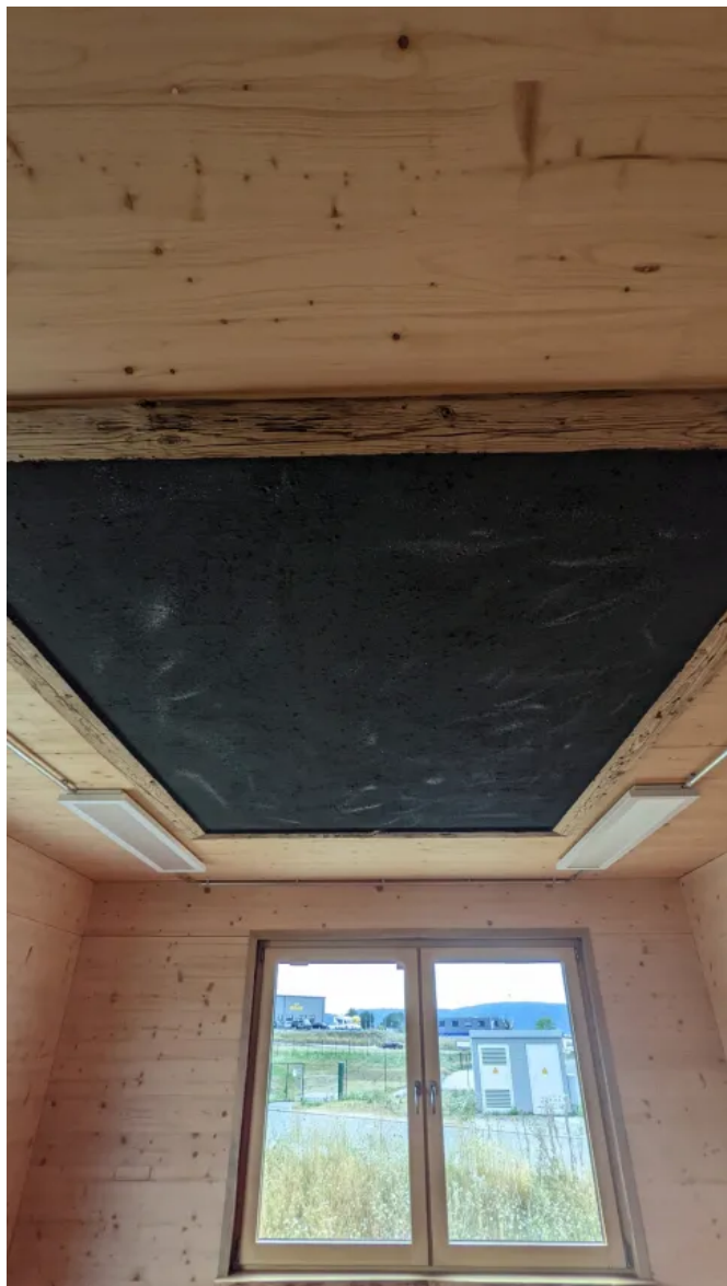
Infrarotheizung verputzt
