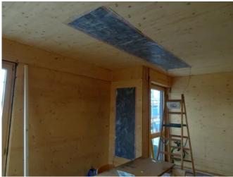
Infrarotheizung an Wand und Decke
